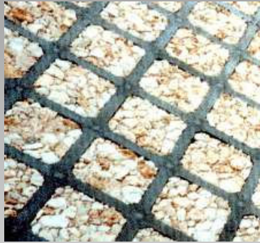
法枠ブロック
